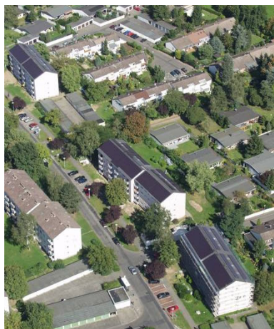
Sanierungen der GSG Neuwied
