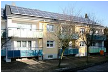
GWG 1897 Köln tauscht stromfressende Nachtspeicherheizungen. Bild: Danne
