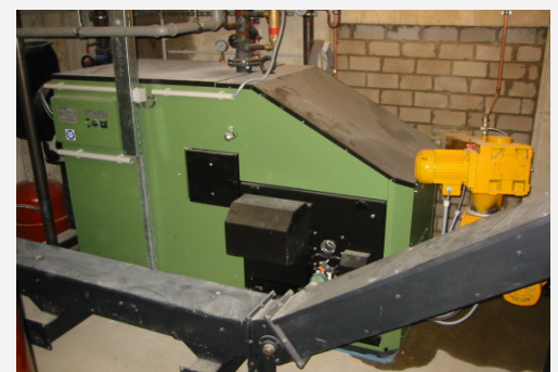
Hackschnitzelkessel 200 kW
